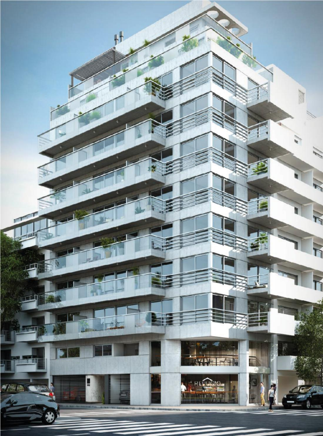
Carpinterías de fachadas en aluminio anodizado natural o color con vidrio laminado de seguridad. Barandas de balcones de hormigón y/o vidrio laminado de seguridad con pasamanos en aluminio anodizado ídem carpintería Ascensor con cabina revestida en acero inoxidable. Puertas de PB en acero inoxidable, puertas en pisos pintadas. Hall de acceso con carpintería de acero inoxidable, pisos y revestimientos de mármol y/o madera y espejos. Iluminación de led en palieres, balcones y espacios comunes.
